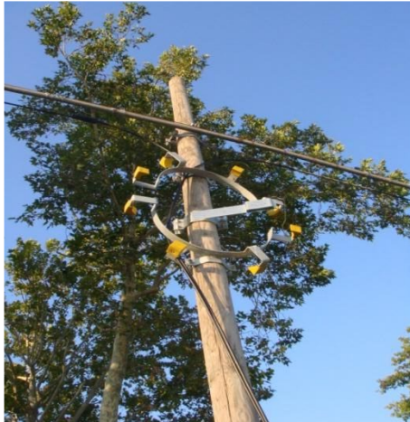
Figura 27 – Esempio sistema di fissaggio per scorta aerea
